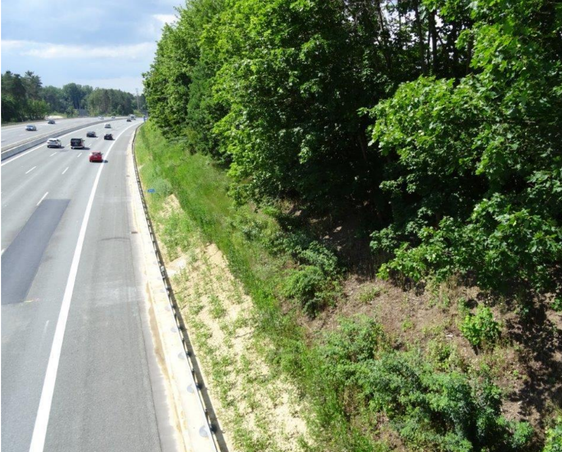
Abbildung 1: Blick vom Bauwerk 399c (Siedlerstraße, Schwaig) nach Nordwesten in Fahrtrichtung Würzburg. Der Ausschnitt charakterisiert recht gut den Aufbau der Reptilien-Habitate im Bereich 4 zwischen Fahrbahn und Gehölzen.
